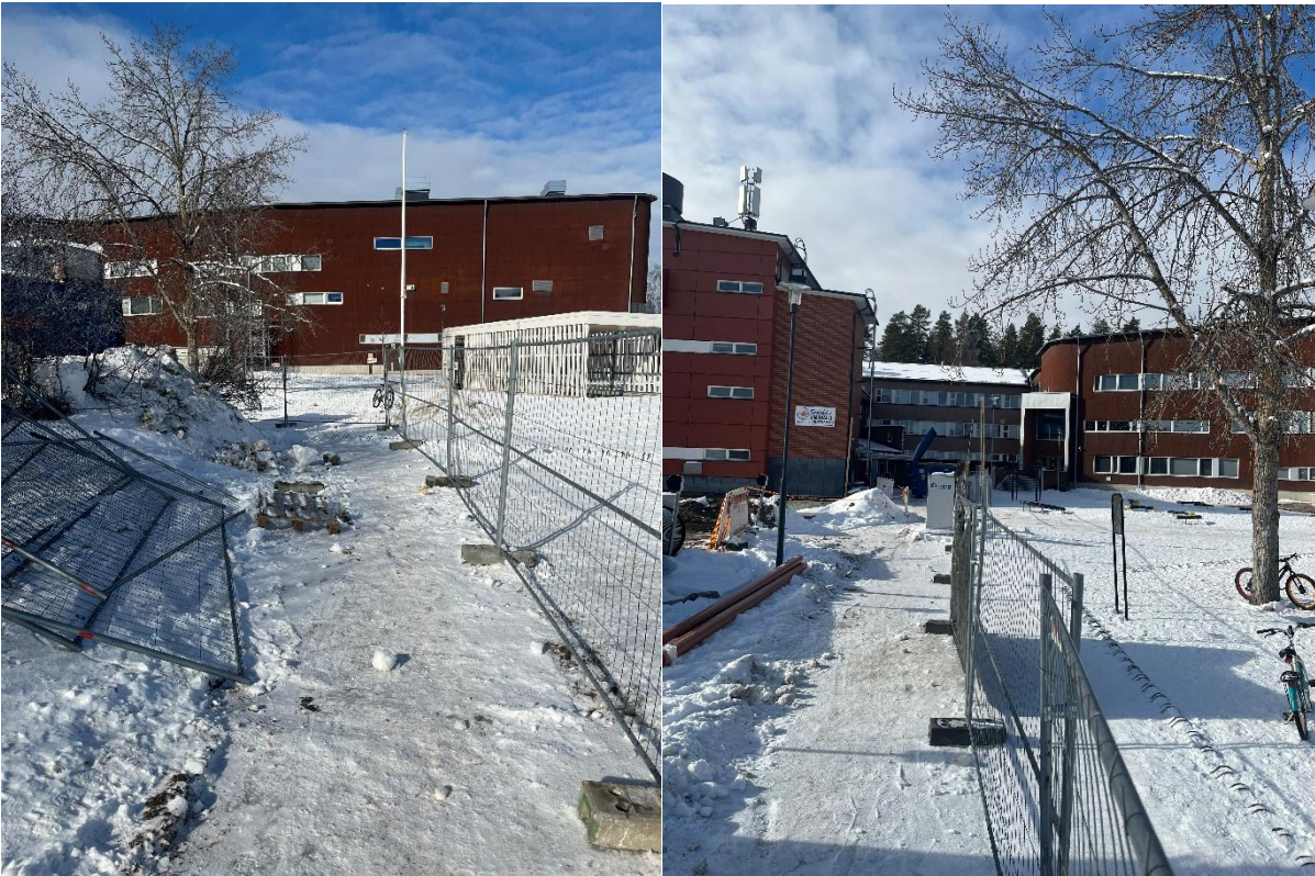
Työmaa-aitauksia jouduttu levittämään maatöistä johtuen.
