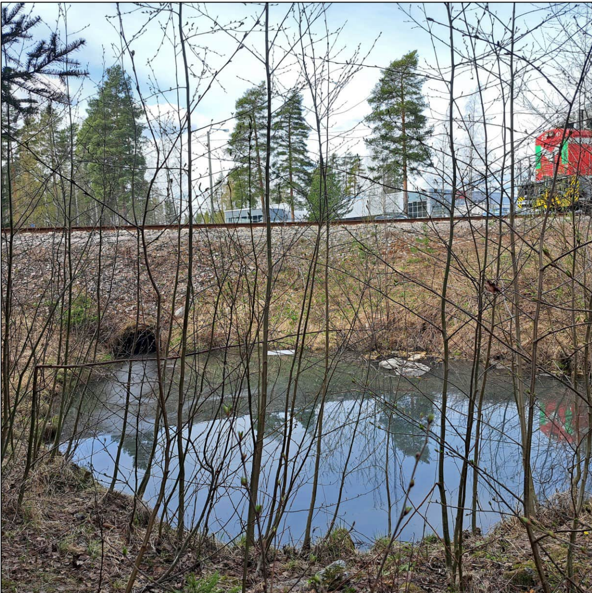
Kuva 68. Kohteelle 6.3. Natura-alueelle Pienen Sirkkalammen rantasuoille lasketaan Valtran tehdasalueen hulevesiä radan ali radan ja kantatien 69 risteyskohdan eteläpuolelta. Kuvaussuunta länsiluoteeseen.
