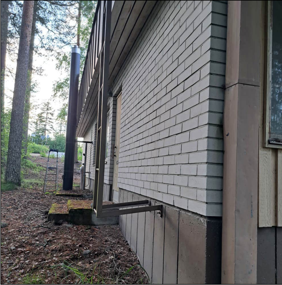
Kuva 72. Yksi passiividetektoreista kiinnitettiin kuvassa näkyvän piipun kylkeen kaiteeseen talon länsisivulle.
