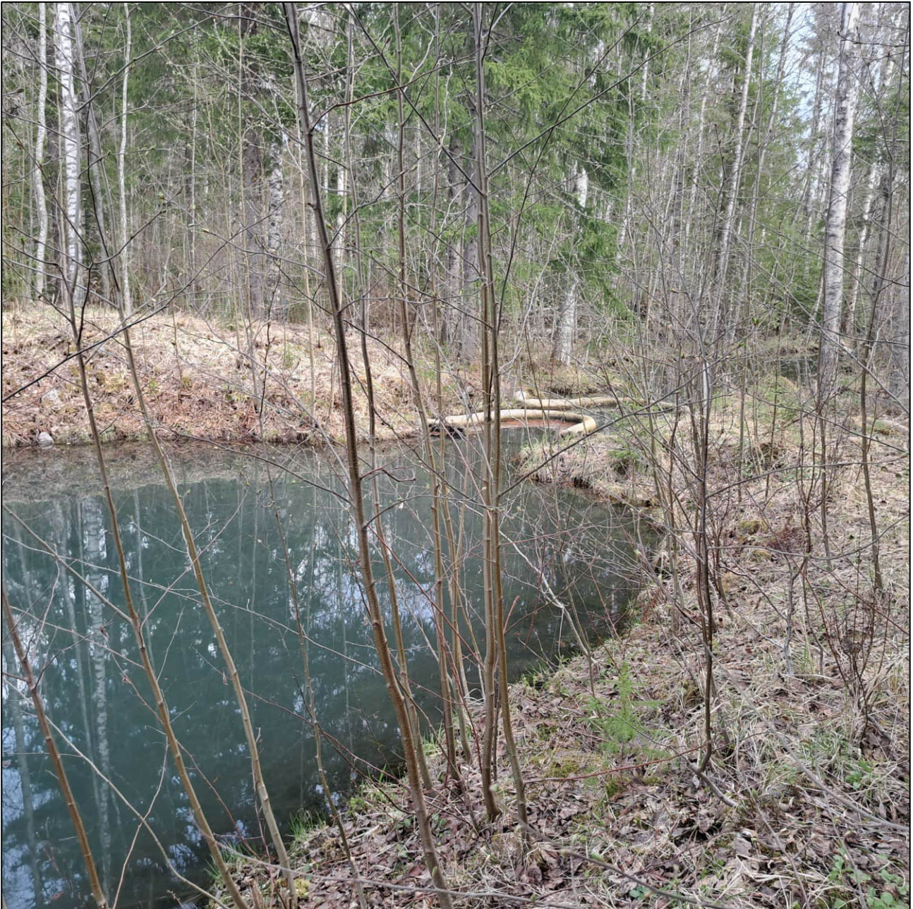
Kuva 69. Kohteelle 6.3. Natura-alueelle Pienen Sirkkalammen rantasuolle lasketaan Valtran tehdasalueen hulevesiä radan ali radan ja kantatien 69 risteyskohdan eteläpuolelta. Hulevesiuomassa on kaksi peräkkäistä laskeutusallasta, joista kuvassa itäisempi. Kuvaussuunta itään.
