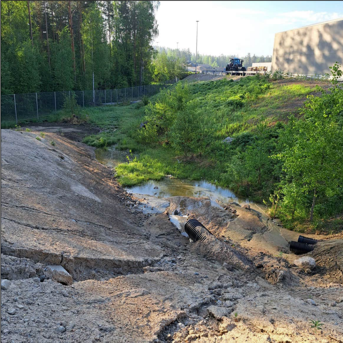
Kuva 64. Kohteen 6.1. viitasammakon lisääntymis- ja levähdyspaikka on pieni lampare tehdasalueen pohjoisosassa hulevesilaskuputken suulla. Kuvaussuunta itään. Kuvauspäivä 29.5.2024.
