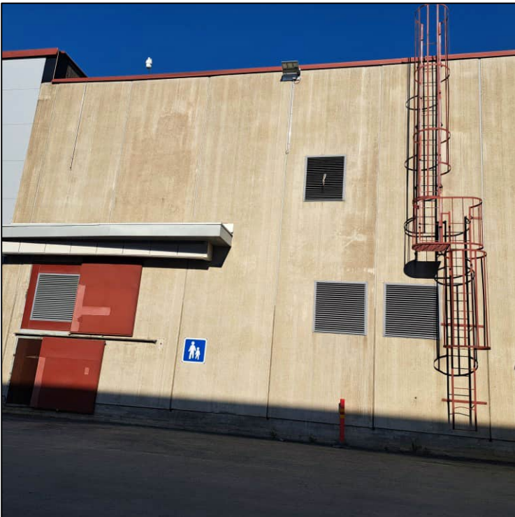
Kuva 50. Kohteen 4.1. tervapääskyn pesäpaikka (ainakin kolme pesää) sijaitsee tehdasrakennuksen kattopellin alla. Kuvaussuunta länteen.
