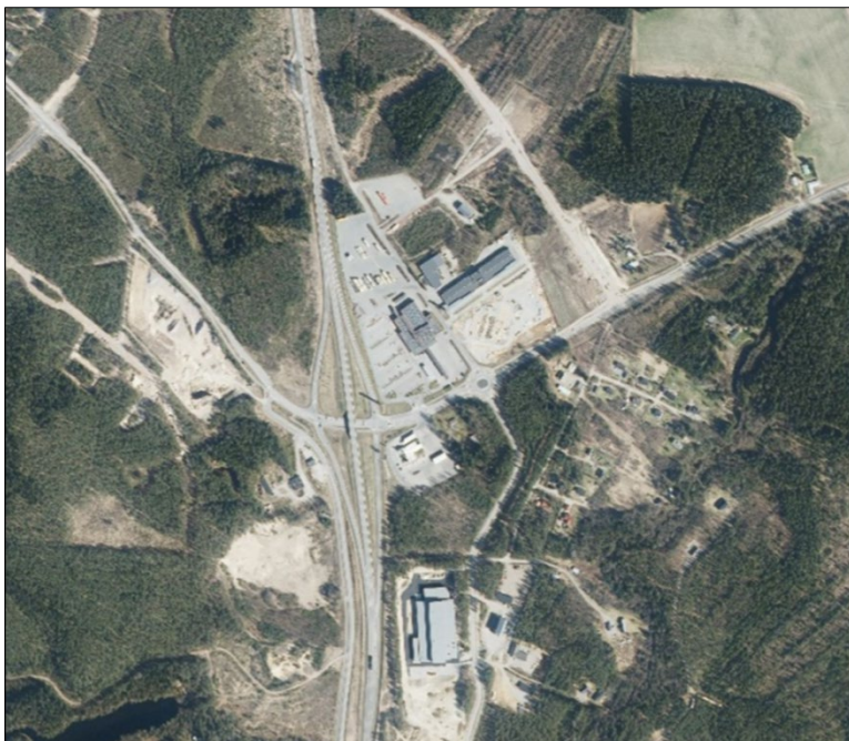
Kuva 1. Ilmakuva Hirvaskankaan alueen rakentunutta rakennuskantaa ja katuverkkoa.
