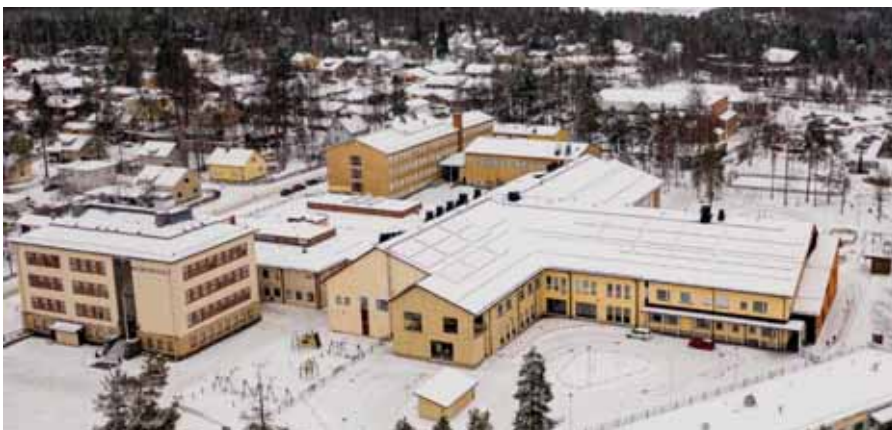
Kuvat 6. Kuvan etuosassa näkyy suojeltu keskuskoulu ja Koulunmäen alakoulu. Takaosassa näkyy nykyinen yhtenäiskoulu, joka on purettu ja tilalle rakennetaan uusi koulurakennus. Kuvassa oleva koulurakennusten ympäröimä matalampi rakennusmassa on purettu. Taustalla puiden takaa näkyy punainen tiilirakennus, Äänekosken liikuntatalo/uimahalli.
