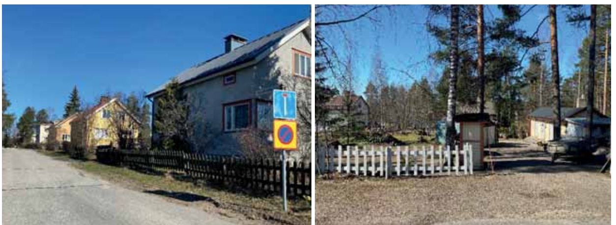
Kuva 14. Louhenkadun varren rakennuskantaa.
