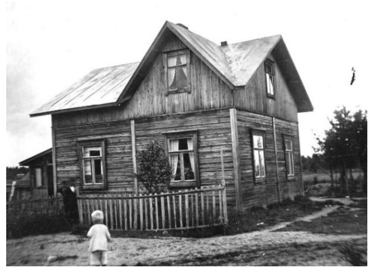
Kuva 13. Asuinrakennuksia Sörkänmäellä. Yllä Suutari Toikkasen talo 1930-luvulla ja alla Höökin talo, jossa toimi useita liikkeitä ja posti. Höökin talossa ensimmäinen kerros oli aluksi hirsipinnalla ja yläkerta verhoitu kapealla pystypuupaneelilla. Kuvat: Vanhan Äänekosken Kotiseutuyhdistyksen valokuva-arkisto
