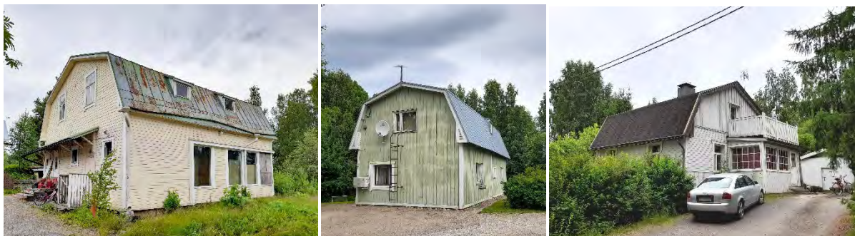
Kuva 21. Höökinkadun mansardikattoisia rakennuksia 1900-luvun alkuvuosikymmeniltä.
